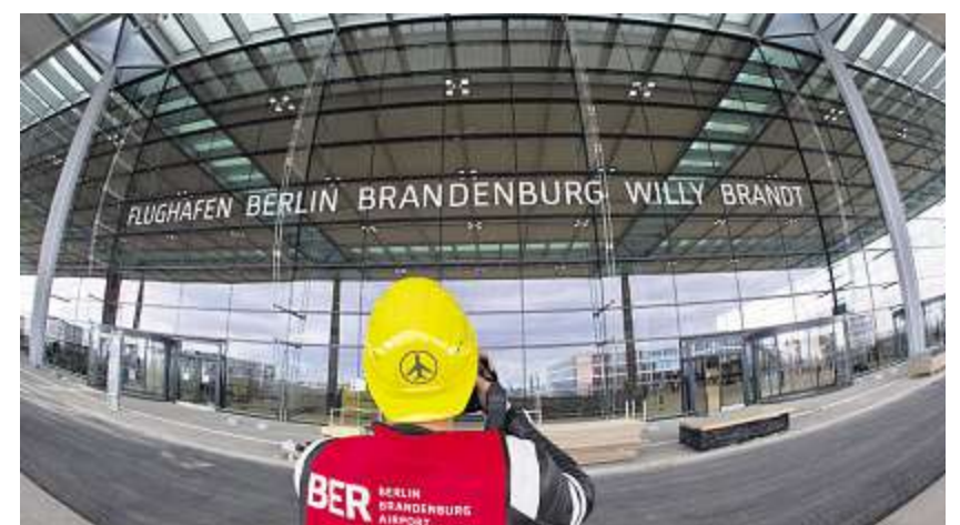
Welche Folgen mangelnder Brandschutz beziehungsweise die Vernachlässigung der Brandschutztechnik haben kann, zeigt sich besonders gravierend am Beispiel des Hauptstadtflughafens Berlin-Brandenburg.
